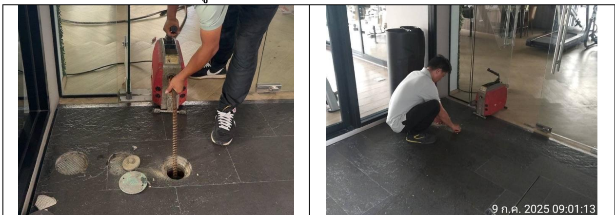
การทำความสะอาดเส้นท่อระบายน้ำเสียของห้องพัก
