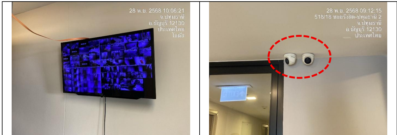
รูปที่ 2-27 ตำแหน่งห้องควบคุม และตัวอย่างการติดตั้งกล้องวงจรปิด (CCTV)
