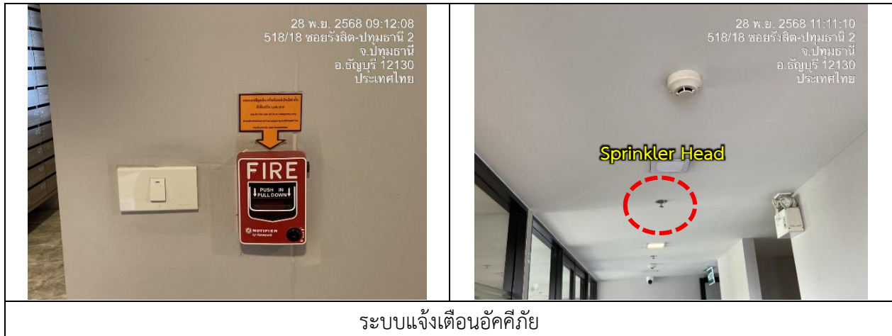
รูปที่ 2-19 ระบบป้องกันและระงับอัคคีภัย (ต่อ)
