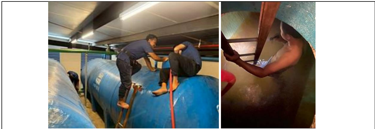
รูปที่ 2-7 การทำความสะอาดถังเก็บน้ำสำรอง
